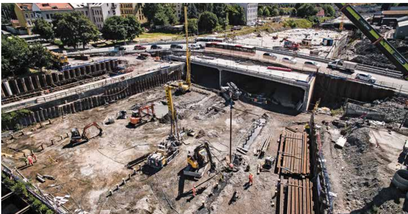
Keller Grundbau behält mit der Telematik-Lösung ROBUSTO auch im Einsatz einen genauen Überblick über den Maschinenpark.
